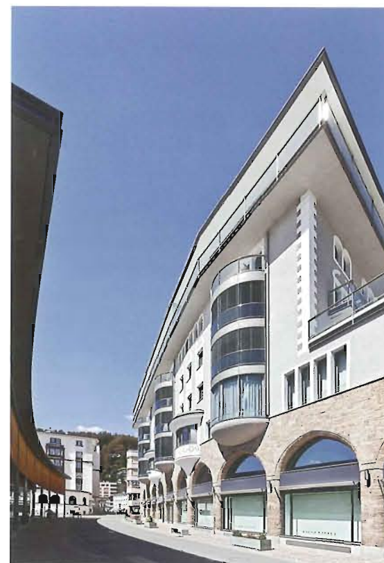
Abb. 5: Hotel Post Veraguth vor 1900 (oben); Neues Posthotel nach 1908 (Mitte); Posthaus, Teil der Zweitwohnungsresidenz «The Murezzan», aktueller Zustand 2011. Foto Michael Peuckert
