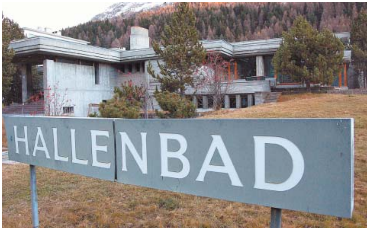
Hallenbad bleibt bis auf weiteres geschlossen: Auch beim vierten Sanierungsversuch des Hallenbades St. Moritz läuft gar nichts rund. Bild Jara Uhrcek
